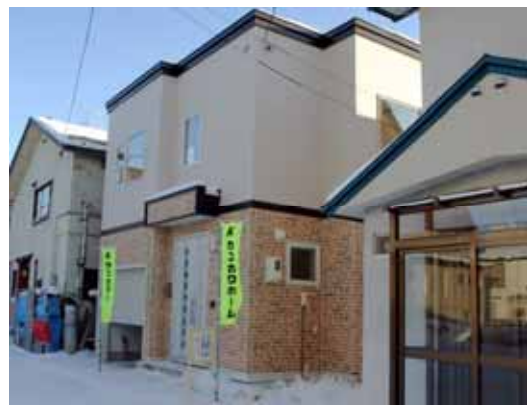
写真3-2 一般住宅 外観
